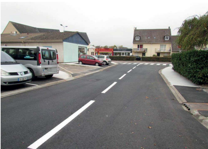
Voirie rue Paul Verlaine
